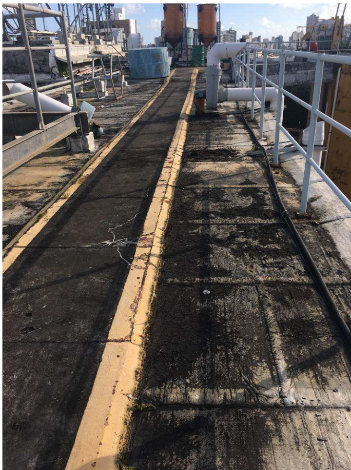
Degradações na manta asfáltica na região de maior pisoteio.
