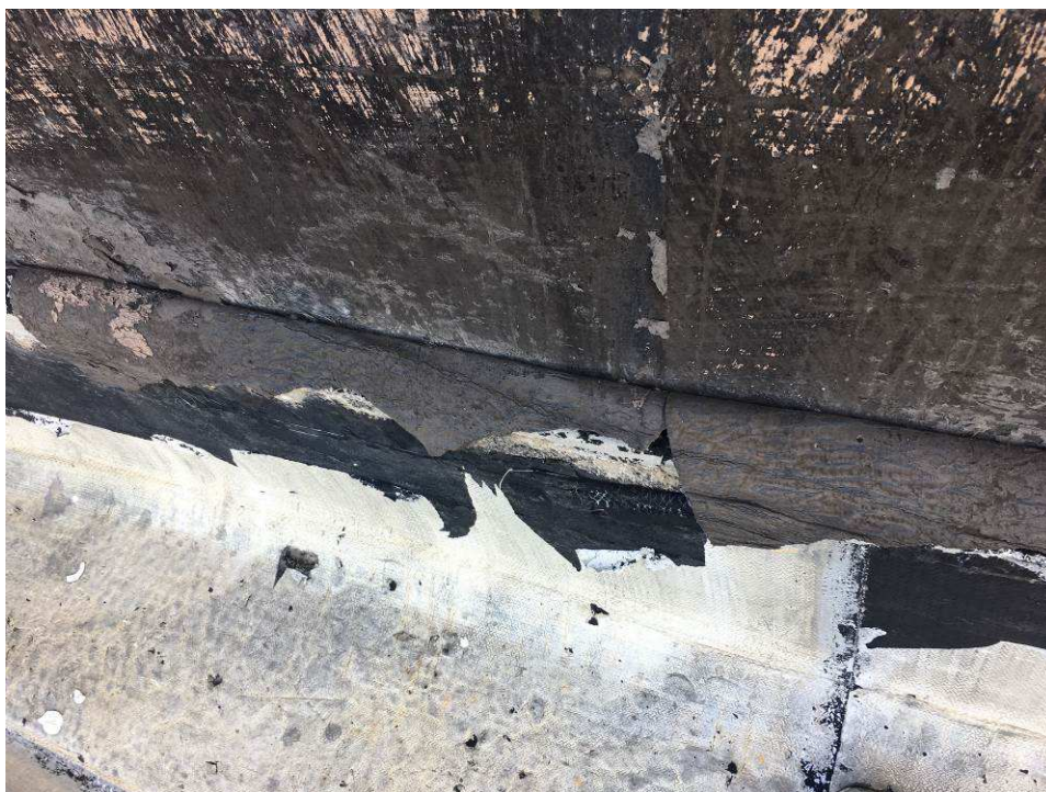
Manta asfáltica descolada em parede inclinada.
