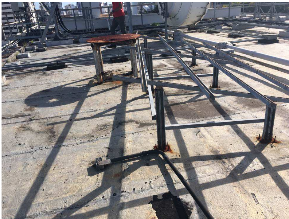
Furações no sistema impermeabilizante.
