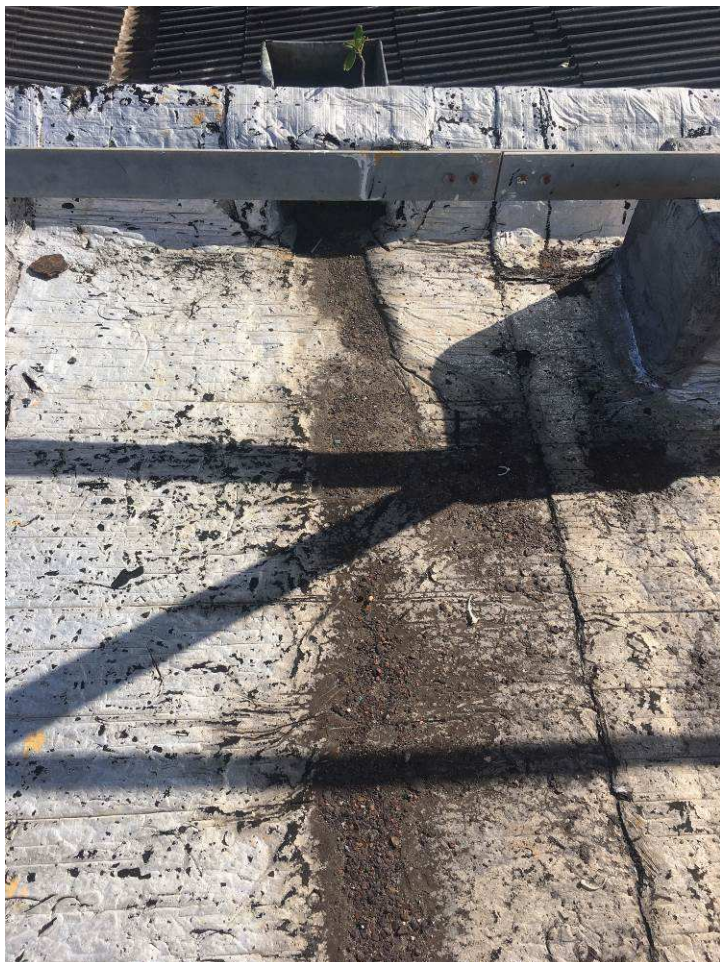
Calha conformada pela declividade na inclinação na proximidade do dreno.
