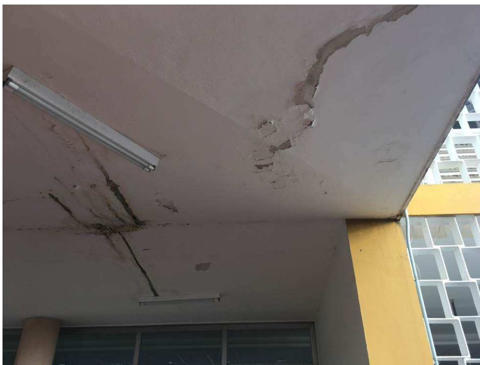
À esquerda, infiltrações relativas à junta estrutural.
