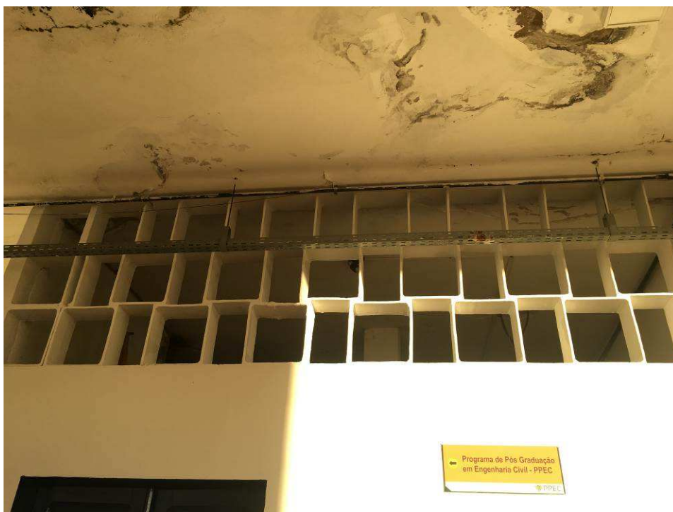
Infiltrações no teto do pavimento inferior (na proximidade da casa de máquinas dos elevadores).
