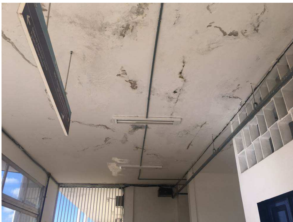
Infiltrações no teto do pavimento inferior (abaixo da área central da cobertura).
