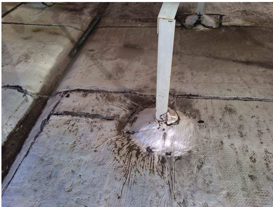
Fixação de equipamento instalado na laje.
