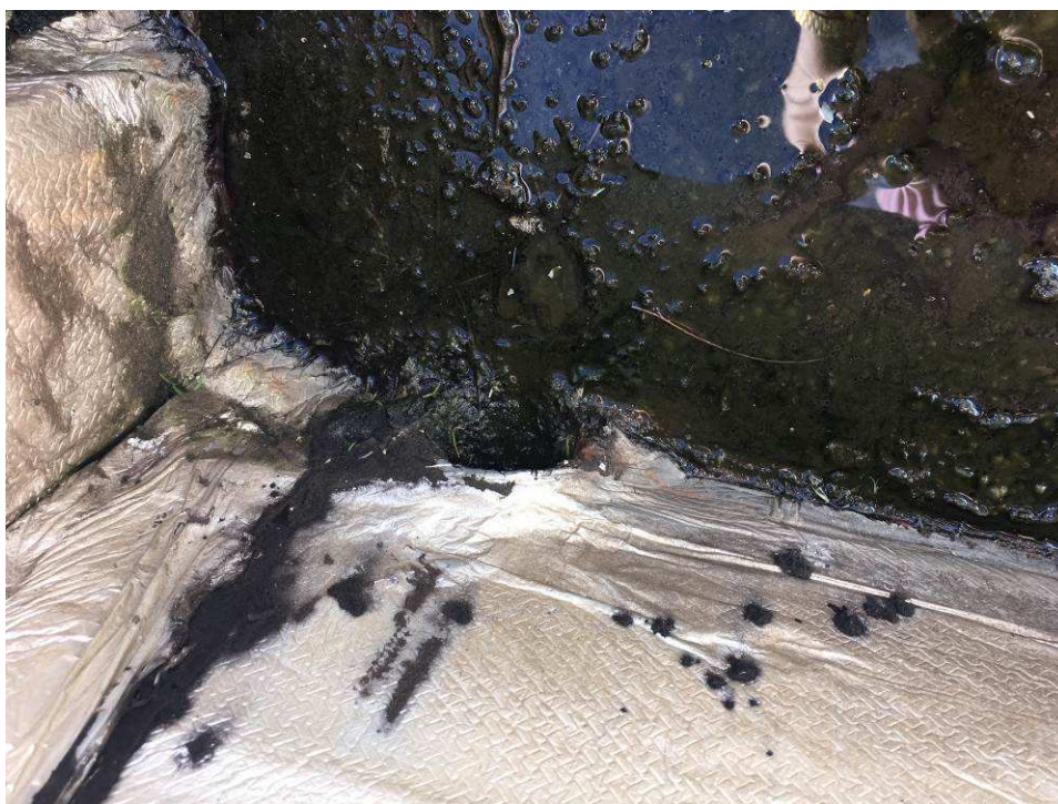
Buzinote visto por dentro da área confinada.
