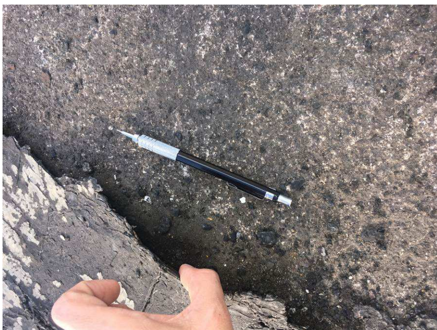
Região onde a manta asfáltica se extinguiu, expondo a regularização.
