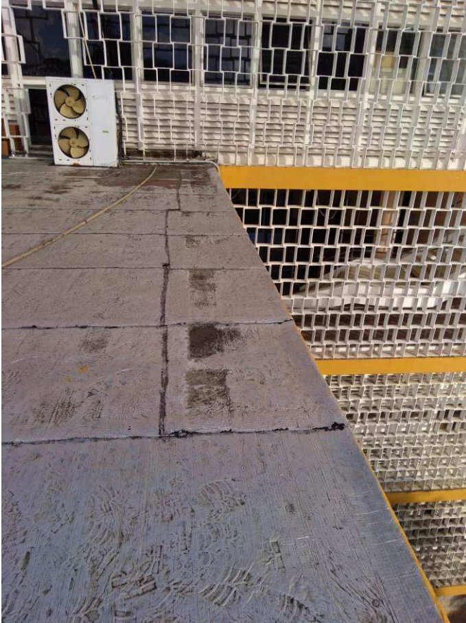
Empoçamentos na sobreposição das mantas asfálticas e marcas de pisoteio. Pequena contenção formada na borda.
