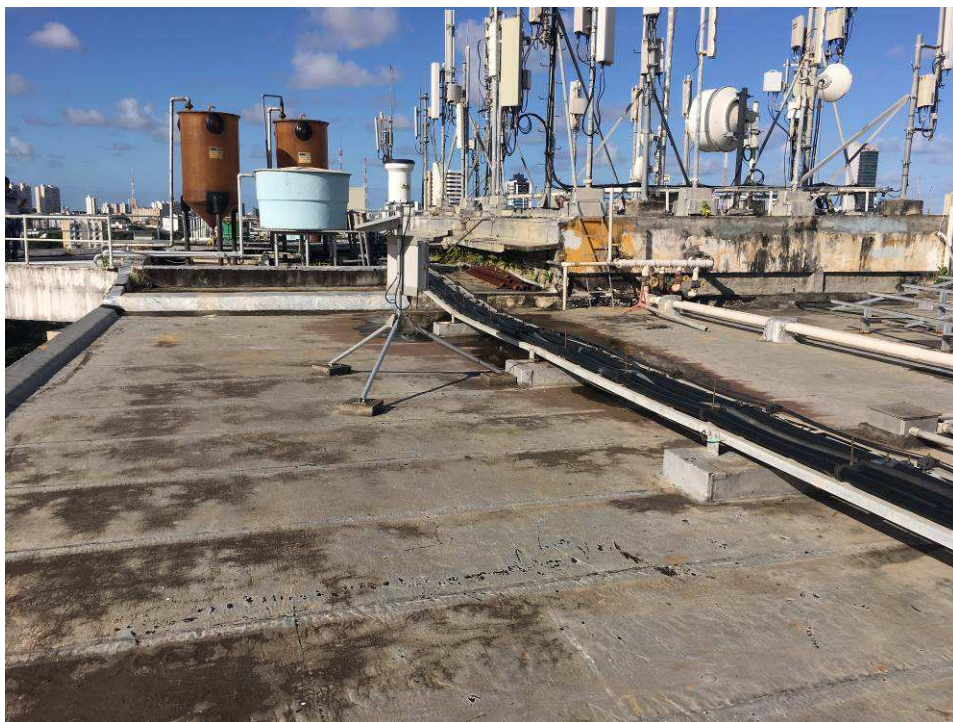
Cobertura impermeabilizada com manta asfáltica aluminizada.
