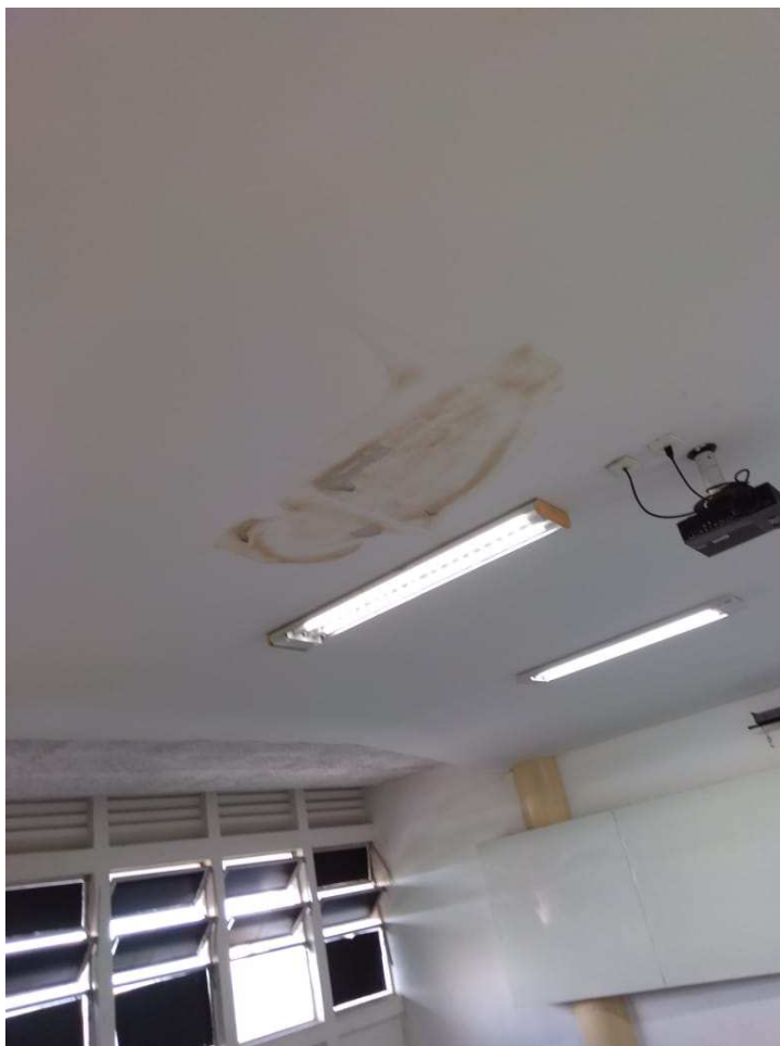
Infiltração em teto de sala de aula.
