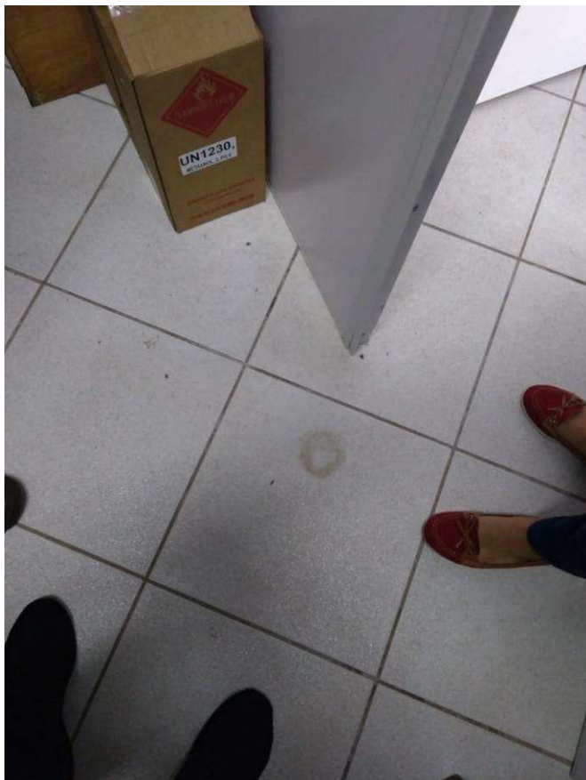
Mancha no piso pelo gotejamento das infiltrações do reservatório inferior.
