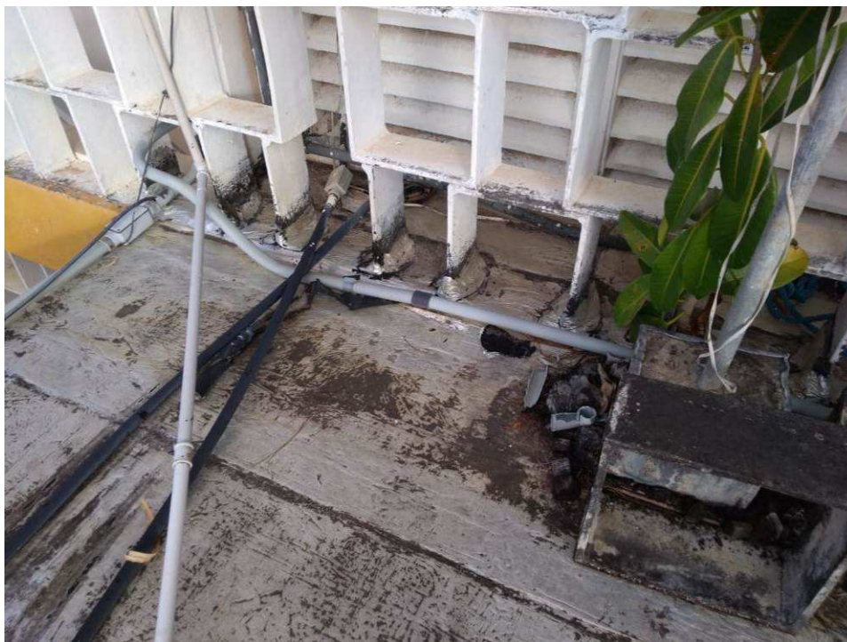
Na parte superior, a junta estrutural foi ignorada.
