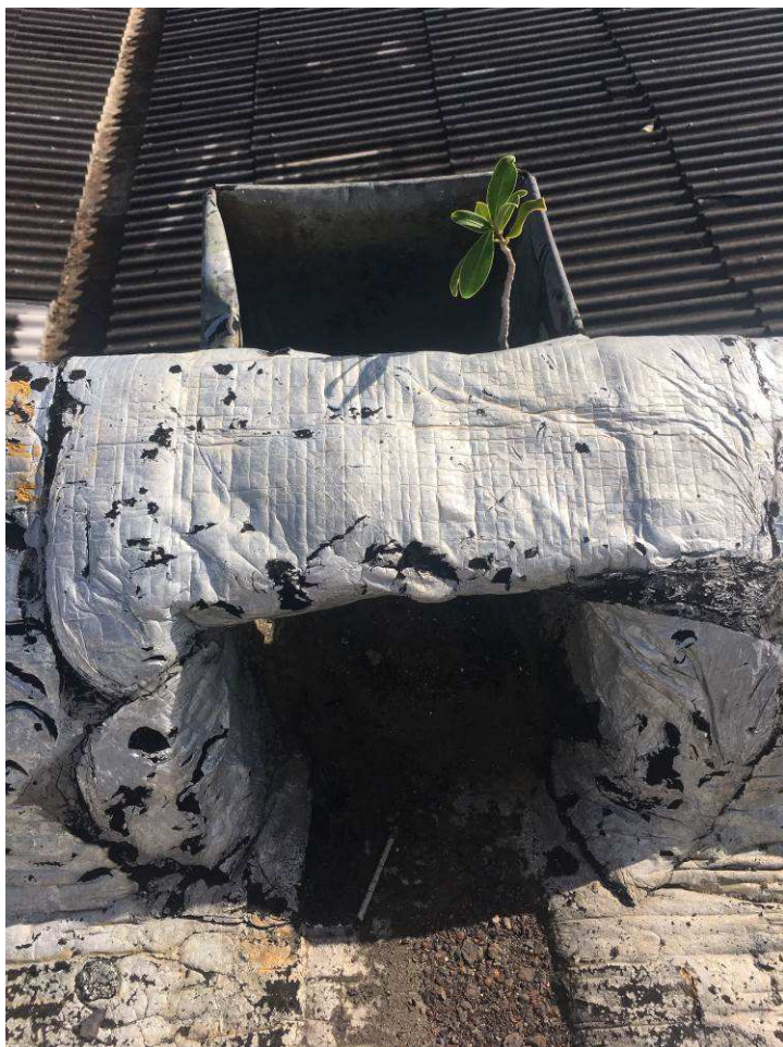
Dreno na extremidade da cobertura.
