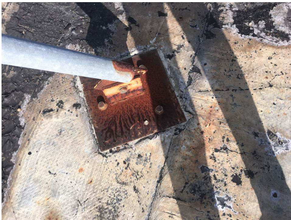
Furação no sistema impermeabilizante.
