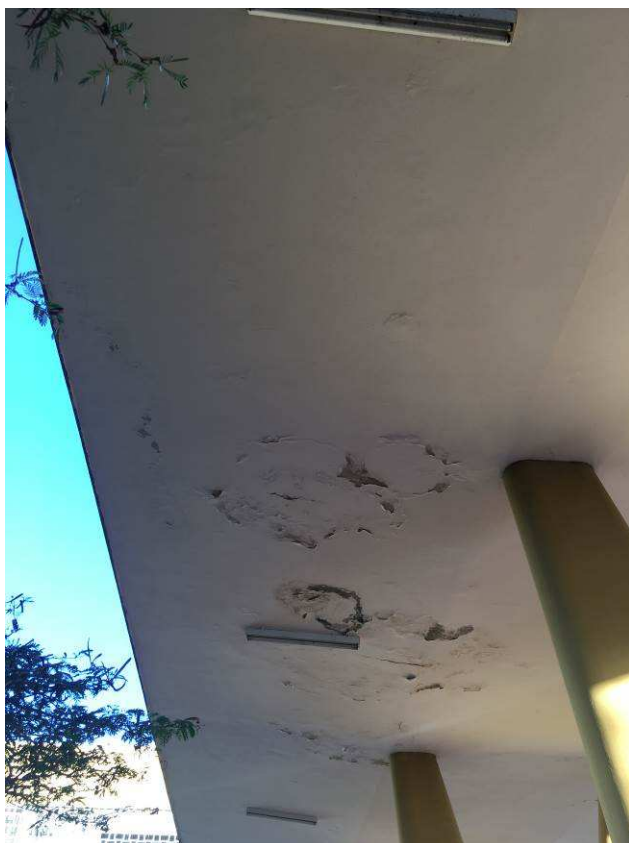
Infiltrações vistas pela parte de baixo da laje.
