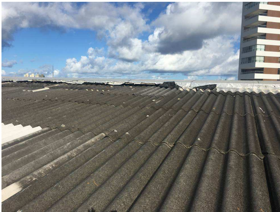
Rufo com pontos rasgados e perfurados.
