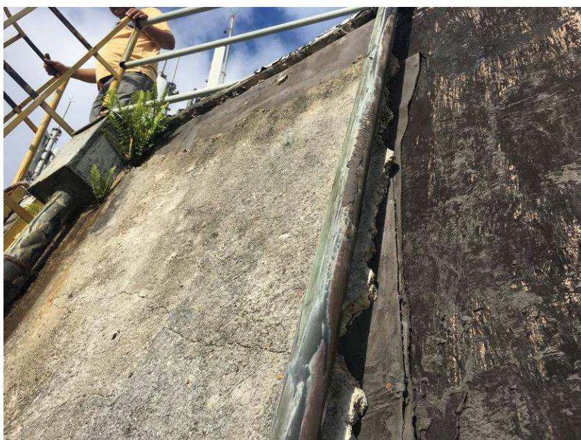
Parede inclinada entre 8º andar e telhado nordeste. À direita, parte da parede onde a proteção mecânica descolou.
