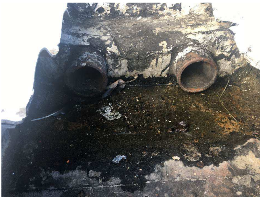
Drenos da calha do telhado a sudoeste, na base da porta de acesso.
