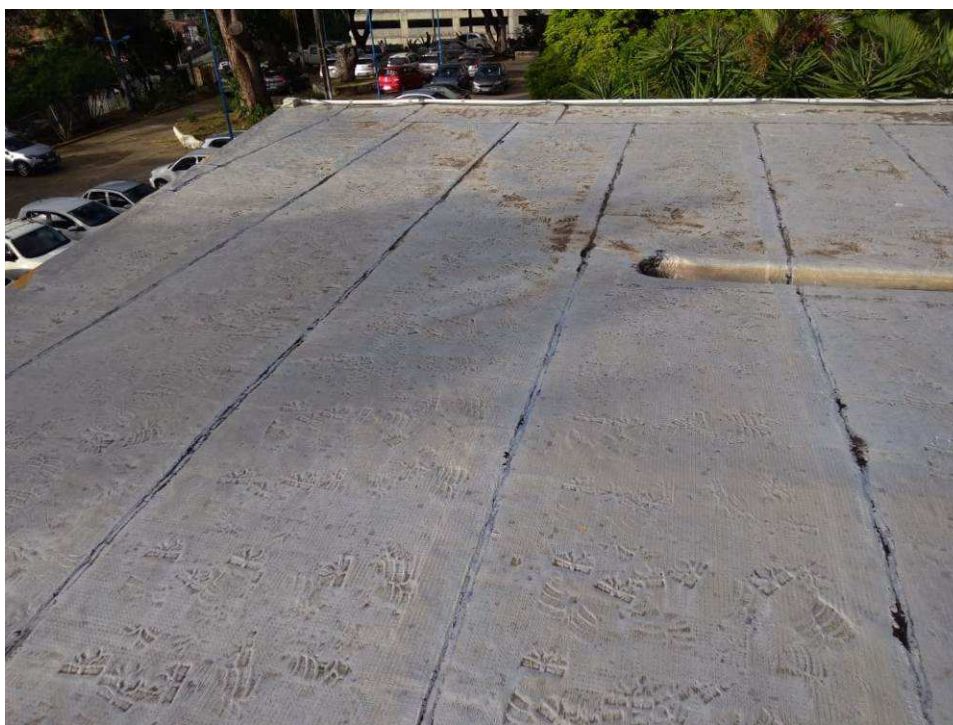
Impermeabilização com manta asfáltica aluminizada. Percebe-se marcas de pisoteio.
