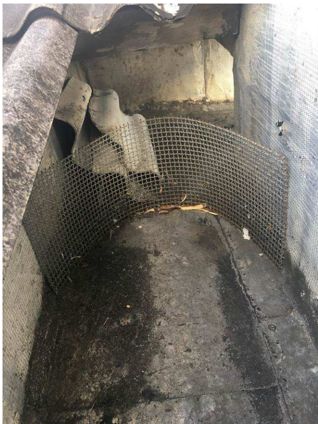
Local do telhado onde a calha desemboca para um dos drenos da extremidade.
