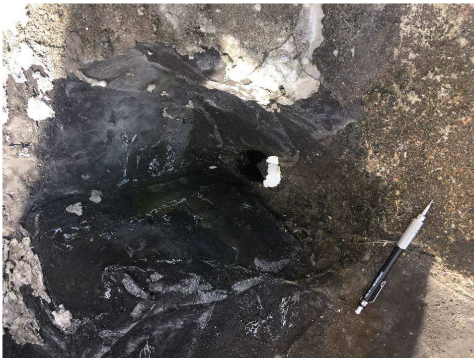
Dreno próximo à parede do reservatório superior.
