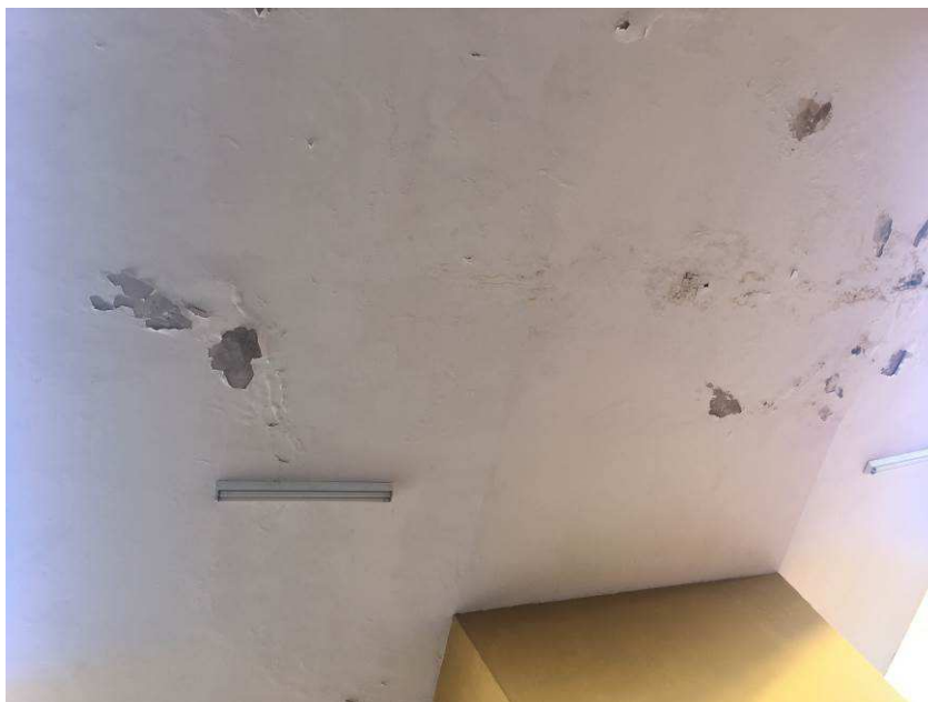
Infiltrações vistas pela parte de baixo da laje.
