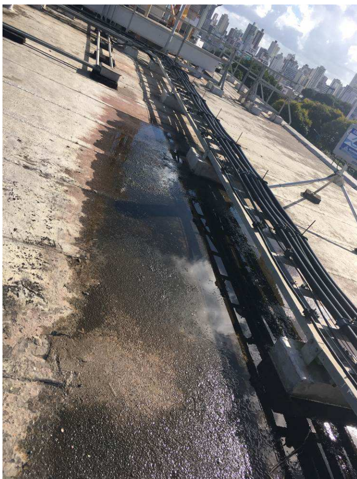
Empoçamento devido ao caimento de piso insuficiente.
