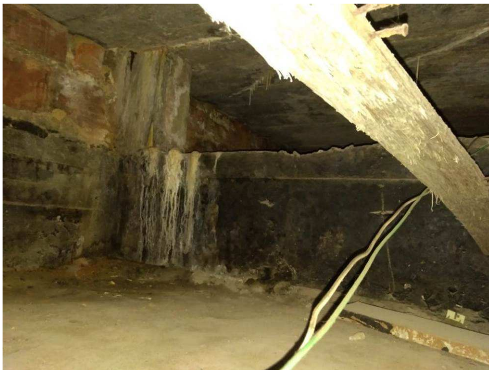
Estalactites e estalagmites na parte inferior a laje de fundo do reservatório superior.
