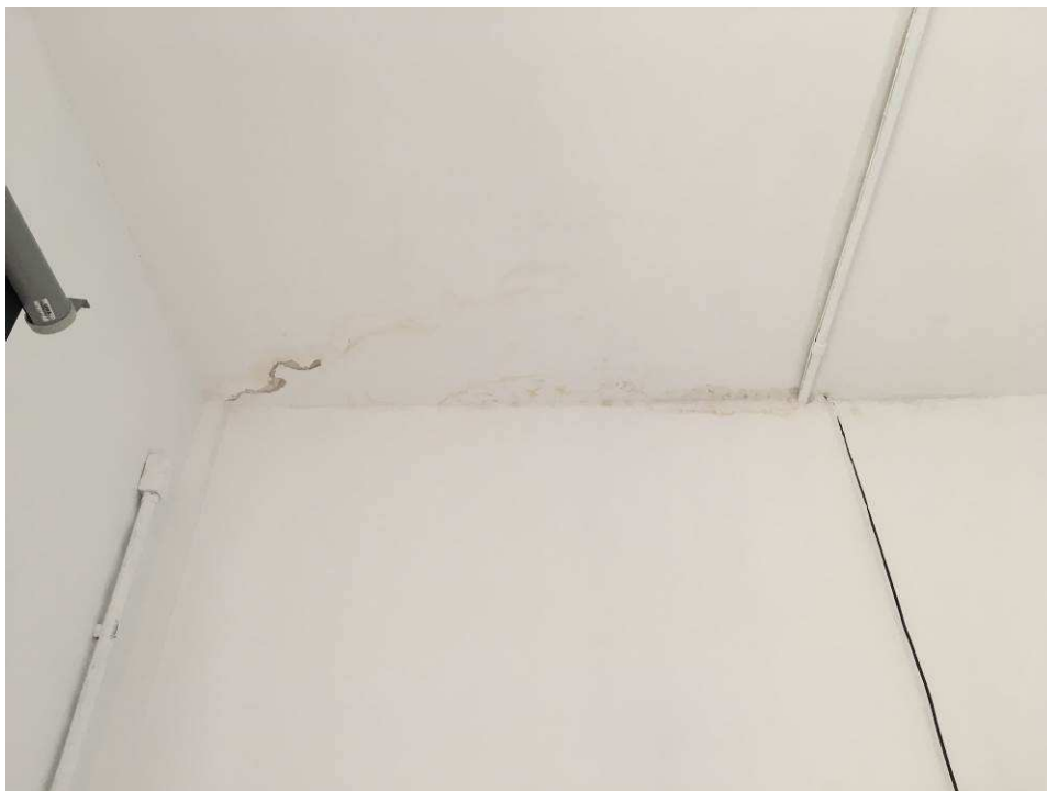
Infiltração em teto de sala de aula.
