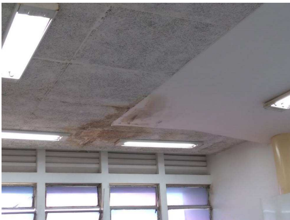
Infiltração em teto de sala de aula.
