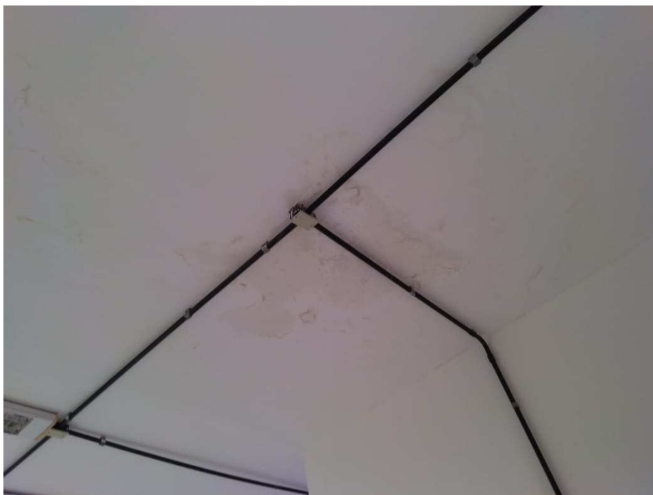
Infiltrações no teto do pavimento inferior (abaixo da área com maior acesso de pessoas).
