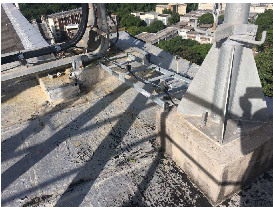
Base em concreto para equipamento.
