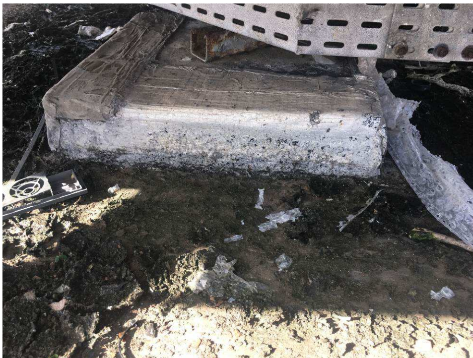
Empoçamento na proximidade dos equipamentos instalados, com acúmulo de sujeira e degradação da manta asfáltica.
