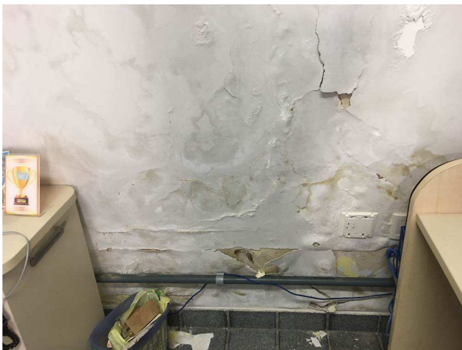
Patologia relacionada a infiltrações na parede inclinada do telhado a sudoeste.
