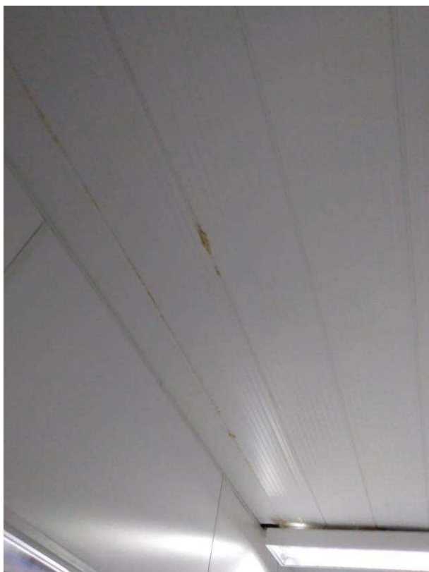
Infiltração no forro do ambiente abaixo do reservatório inferior.
