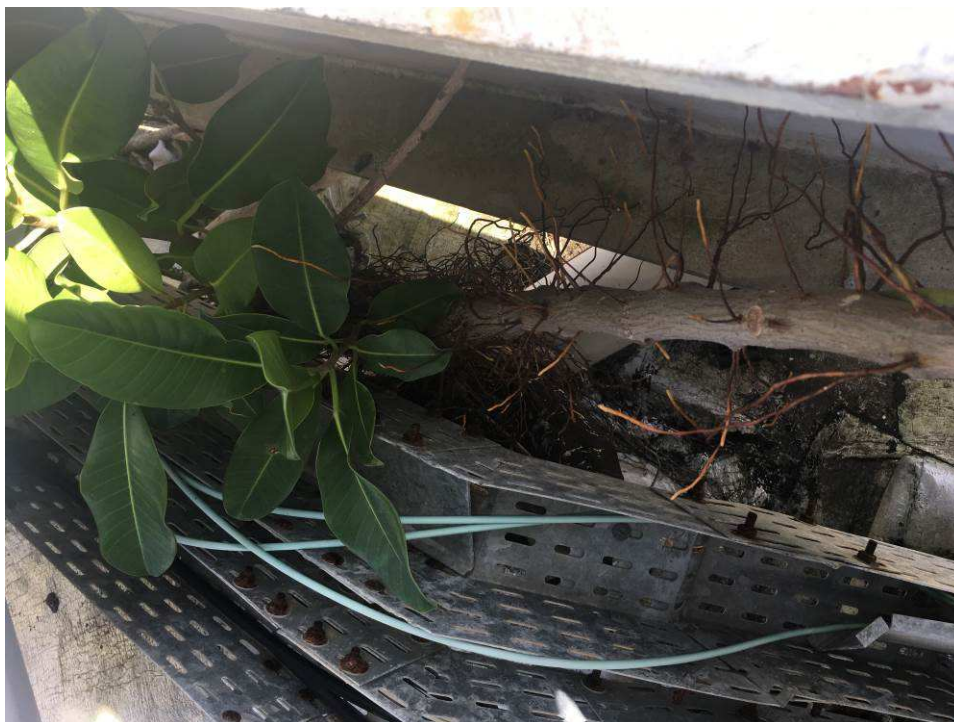
Crescimento de plantas na cobertura colocam em risco a impermeabilização.
