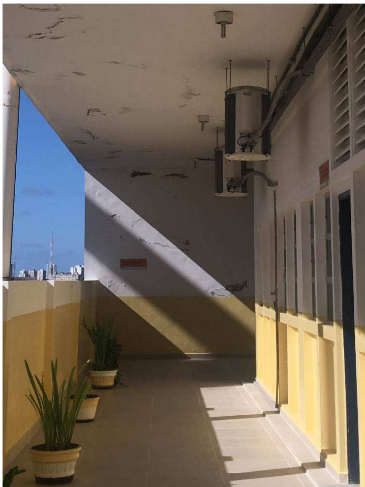
Patologia relacionada a infiltrações na parede inclinada do telhado a nordeste. Esta parede foi pintada recentemente.
