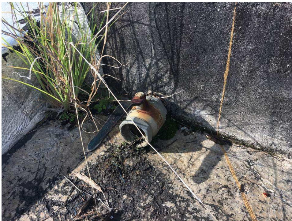
Buzinote para passagem de água confinada por muretas.
