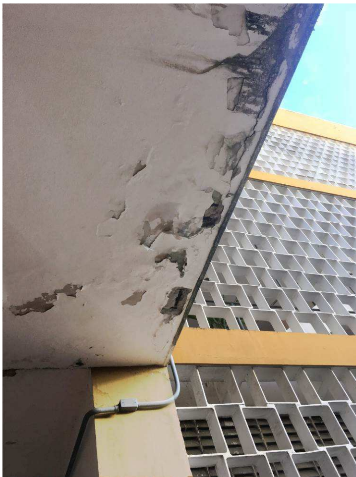
Patologia associada à água de percolação pela face inferior da laje e ao empoçamento na parte superior.
