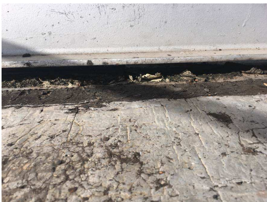
Degradação da manta asfáltica pela ação do tempo, em área de pouco acesso.
