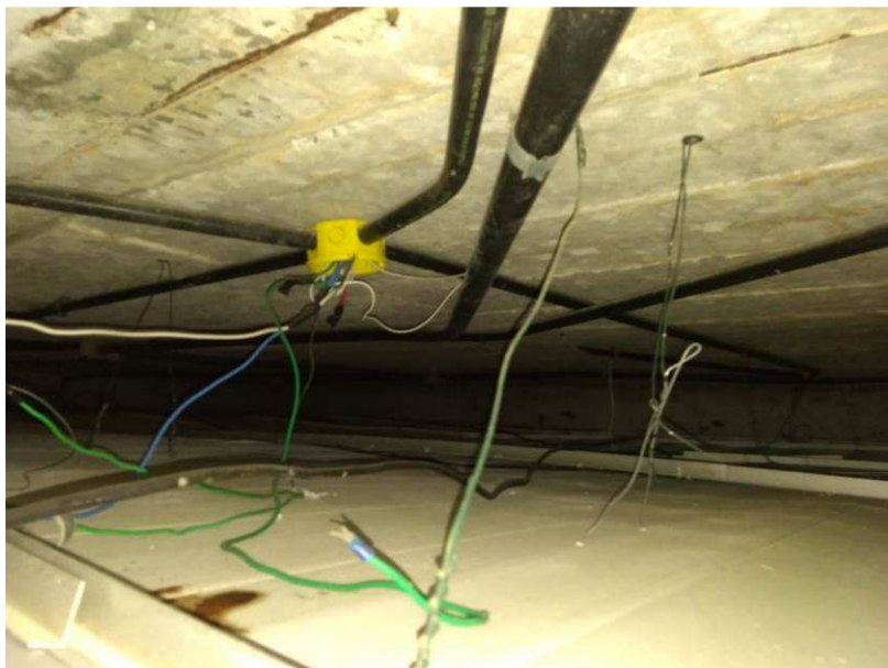
Infiltração da laje de piso do reservatório inferior pingando no forro.
